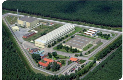
Betriebsgelände in Gorleben mit Transportbehälterlager
